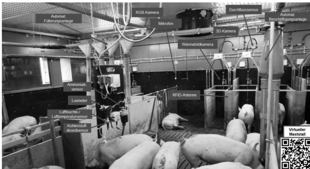
Abbildung 1. Mit vielfältiger Sensortechnik ausgestattetes Mastabteil im „Experimentierfeld DigiSchwein“ auf der Versuchsstation für Schweinehaltung in Bad Zwischenahn-Wehnen.
